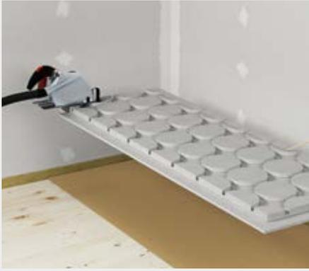
Absägen des überstehenden Falzes für die erste Verlegereihe (analog **fermacell** Estrich-Elemente)
