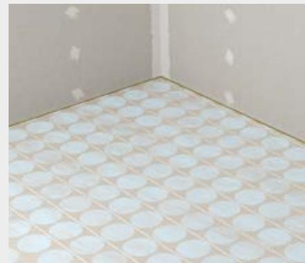
Fertig ausgegossene Therm38-Elemente (Q1)
