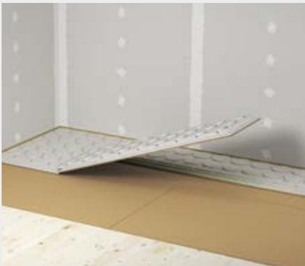
Verkleben der Therm38-Elemente mit vollständig gefüllten Fugen
