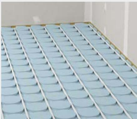
Einlegen der 16 mm Fussbodenheizrohre
