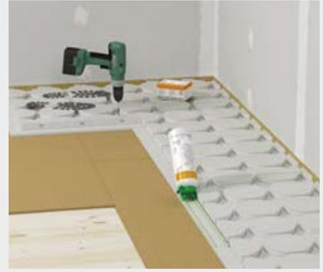
Auftragen des **fermacell** Estrich-Klebers greenline im Falzbereich
