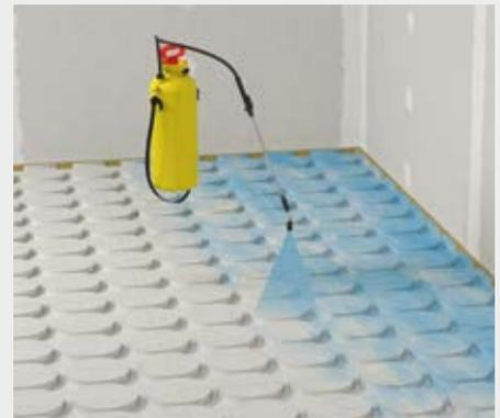
Grundieren der **fermacell** Therm38-Elemente mit **fermacell** Tiefengrund
