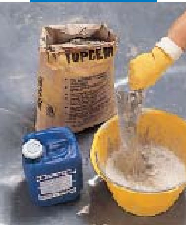
Herstellung einer geeigneten Haftschrämme mittels Topcem und Planicrete
