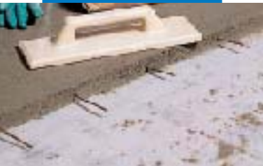
Topcem-Estrich-Verdübelung im Bereich der Arbeitsfugen
