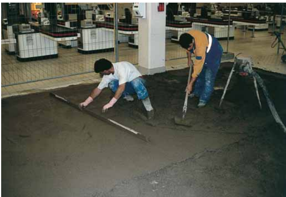
Estrichreparatur mit Mapecem im Supermarket
