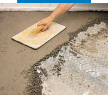
Leitungsüberbrückung mit Mapecem-Estrich
