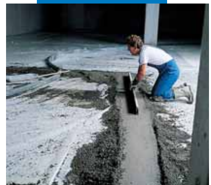
Herstellung von Estrichlehren mit Mapecem-Estrich
