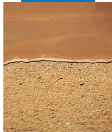
Spachtelung des Mapecem-Estrichs mit Ultraplan
