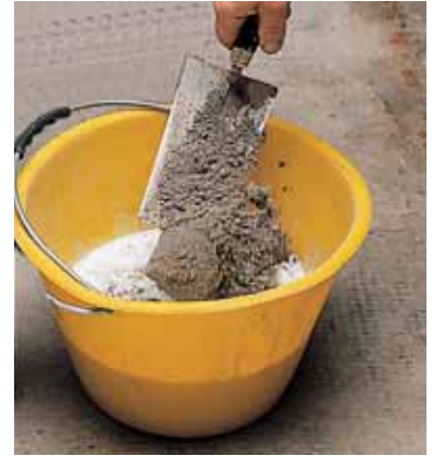
Herstellung einer Haftschlämme aus Planicrete, Wasser und Mapecem
