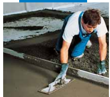
Glätten des Mapecem-Estriches
