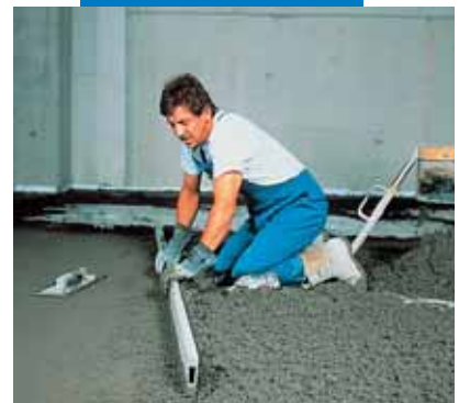
Abziehen des Mapecem-Estriches
