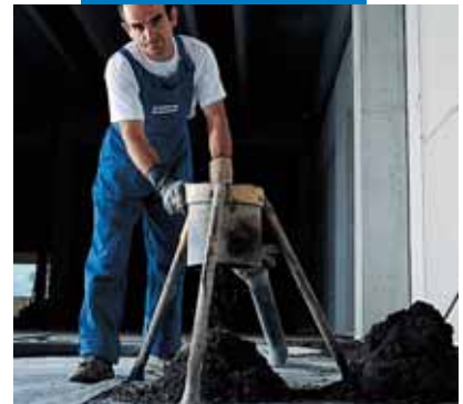
Mapecem-Estricheinbringung mittels Pumpe
