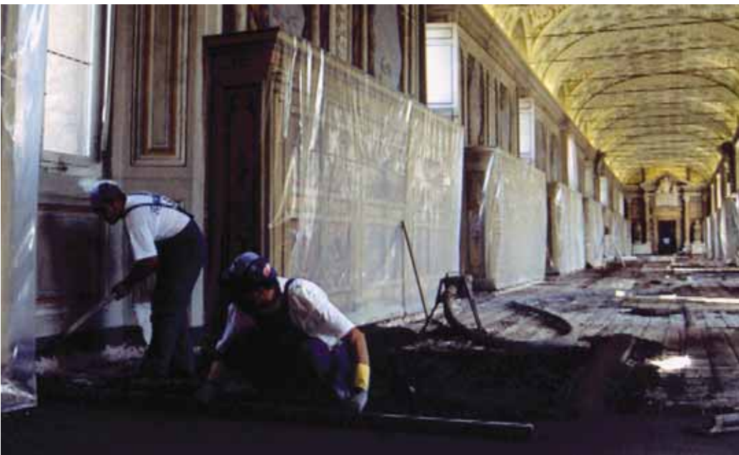
Einbringen eines Mapecem-Estriches - Sixtinische Kapelle - Vatikan
