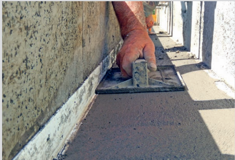
Das mauerkroneprofil dient als Lehre beim Abziehen der Mauerkrone.
