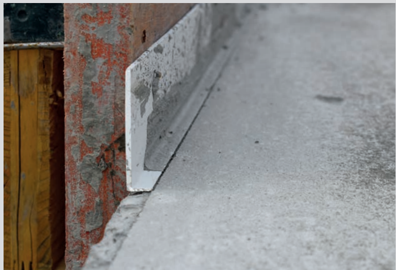
Das Winkelprofil ist an der Längsseite an die Schalung genagelt.
