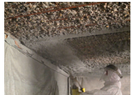
PCI Nanocret R4 SA zum Reparieren und Reprofilieren von beanspruchten Betonbauteilen.
